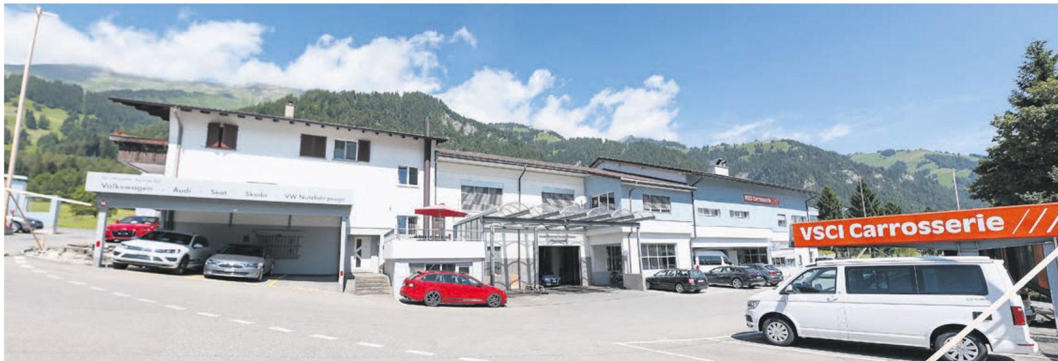
Hinter dem Autohaus von Känel AG wird die Betonplatte errichtet, auf der nächstes Jahr die neuen Showräume gebaut werden. Darunter sollen die Carrosserie und die Waschanlage und weitere Arbeitsplätze eingerichtet werden.
