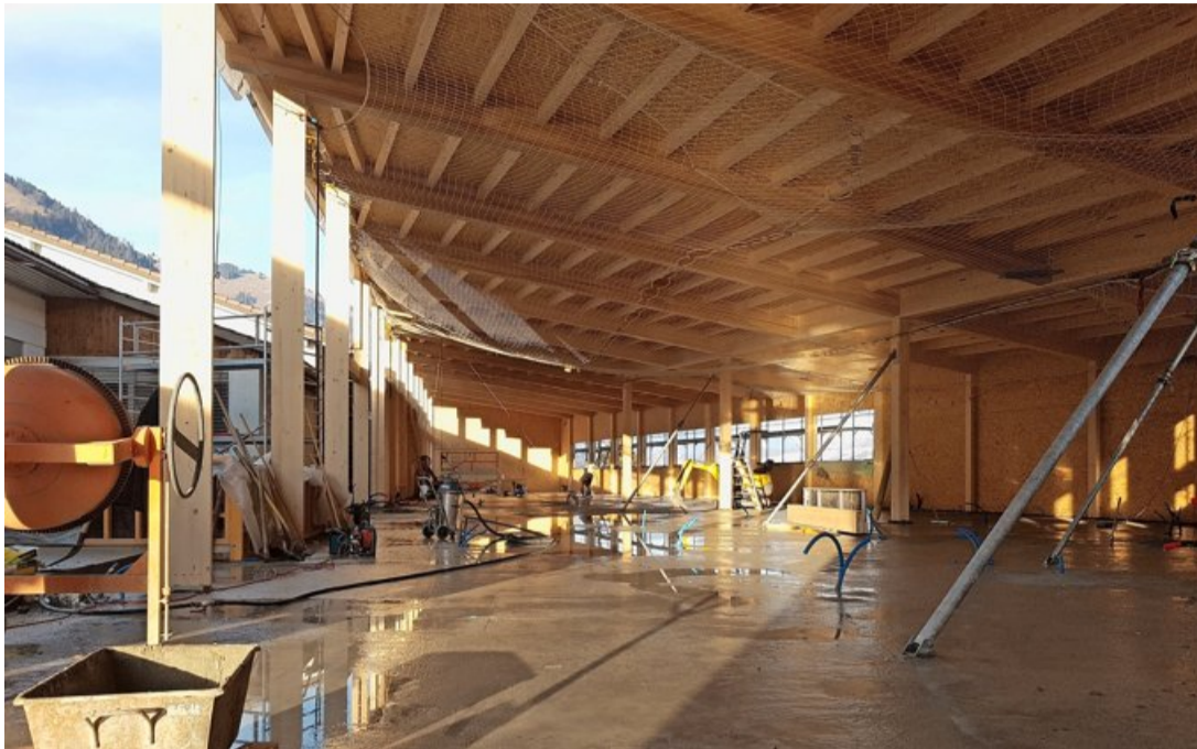
Blick in das obere Geschoss des Neubaus mit den künftigen Ausstellungsräumen und Büros.
